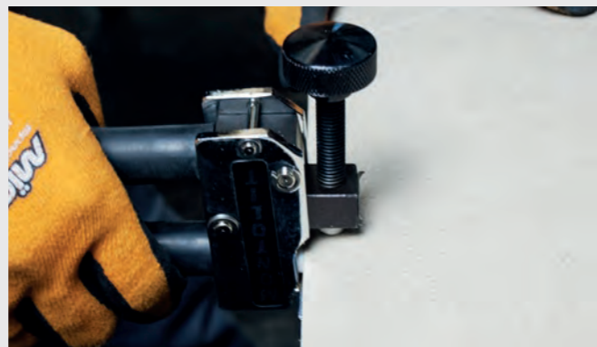
PARTITION OF THE SLAB ON BOTH SIDES OF THE CUT DONE PARTICIÓN DE LA PIEZA EN AMBOS LADOS DEL CORTE REALIZADO
