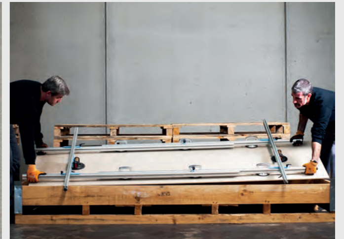
UNBOXING THE SLAB WITH RIGID FRAMES WITH SUCTION CUPS EXTRACCIÓN DE LA PIEZA DE GRAN FORMATO CON BASTIDOR CON VENTOSAS
